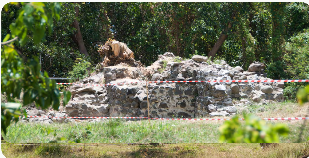
Le four à chaux
