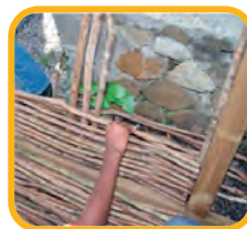
Le bois Ti-Baume à l'horizontale pour les parois tressées en palissades
